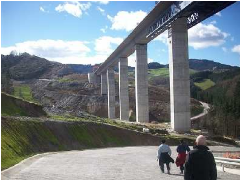
Viaduc en construction sur le Y basque près d'Aramaio (Gipuzkoa)
